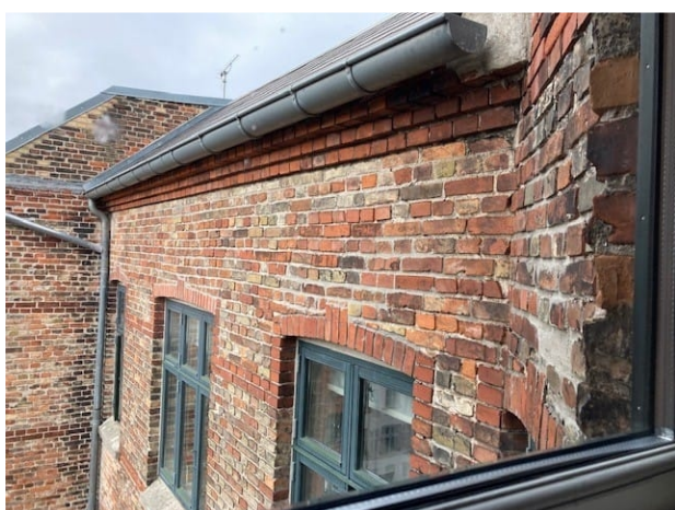
Eksempel murstensfacadens tilstand "øvre facade gård"
