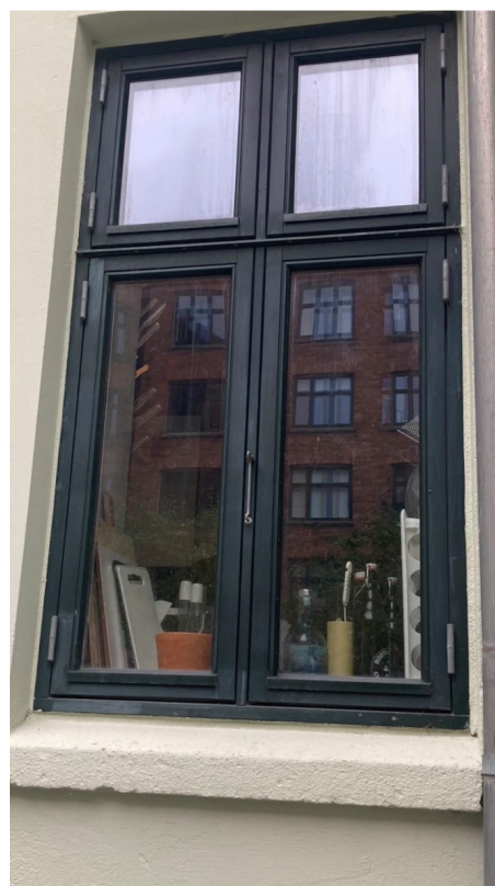
Endnu et eksempel på gård vindues tilstand her maling i nedbrudt tilstand
