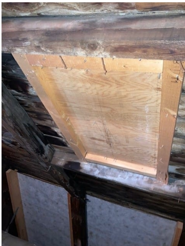
Billede af de synlige hvide saltudtræk og de forskellige løsninger
