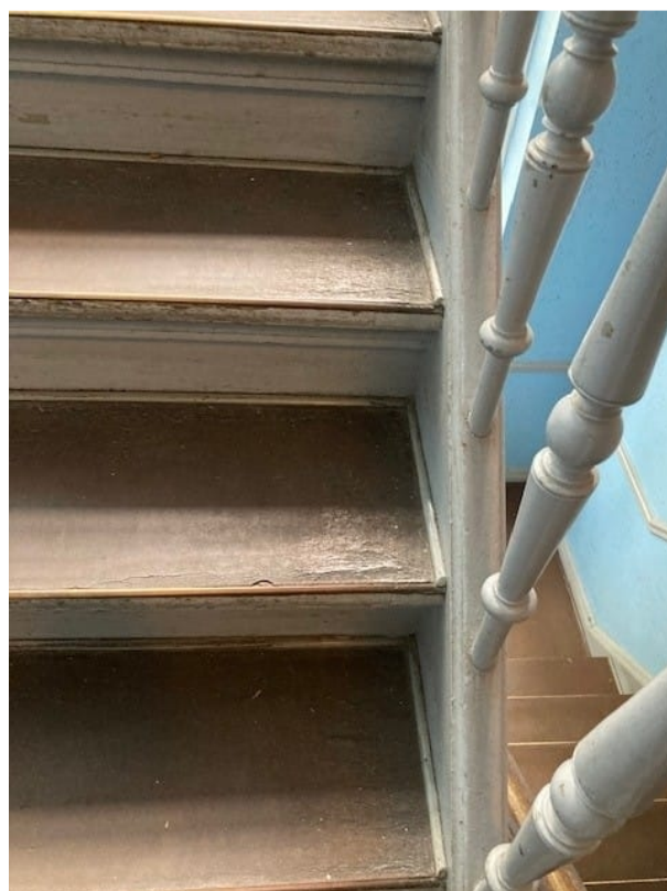
Endnu et eksempel på den dårlige belægning som bør udbedres inden der kommer følgeskader
