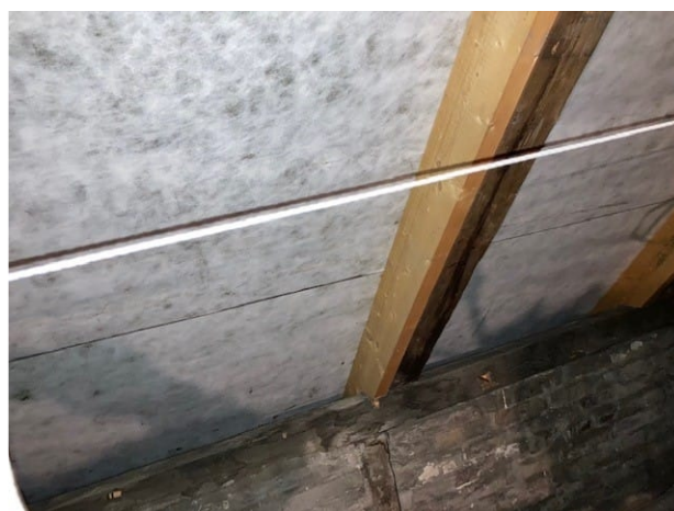
Undertag i banevare, eksisterende spær påforet med nyt spær træ for opretning
