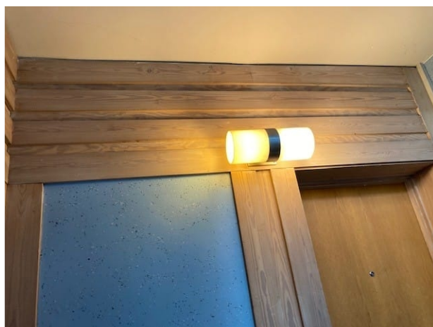
Belysning i hovedtrappeopgangene er af ældre dato ligeledes bek-lædning omkring lejlighedsdørene
