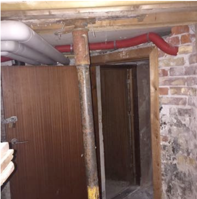
Understøtning af bjælke med soldat
