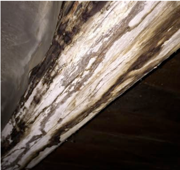
En del af spærkonstruktionen
