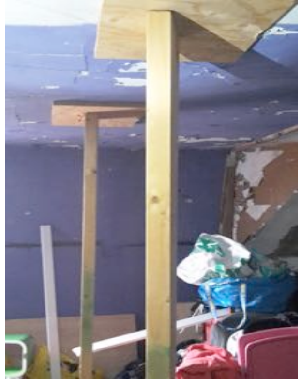
Interimistisk understøtning af tag
