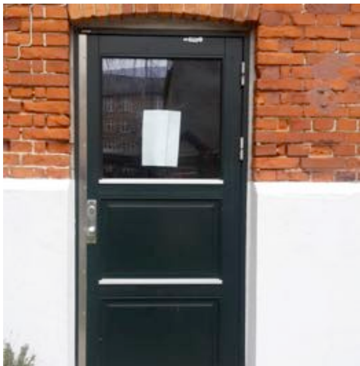
Dør til bagtrappe
